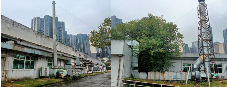
废气处理设施（部分）
